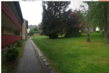
Erneuerung Hauszugangsweg Am Fuchsberg
