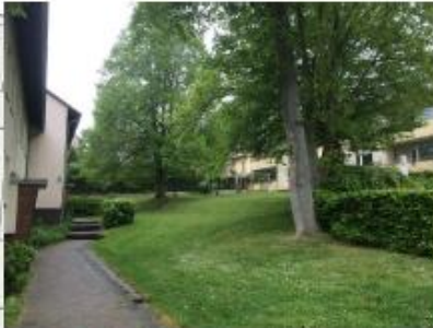
Erneuerung Hauszugangsweg Baunsbergstr. 23-25
